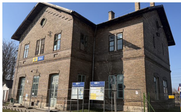
Az 1882-ben épült ácsi vasútállomás épülete
