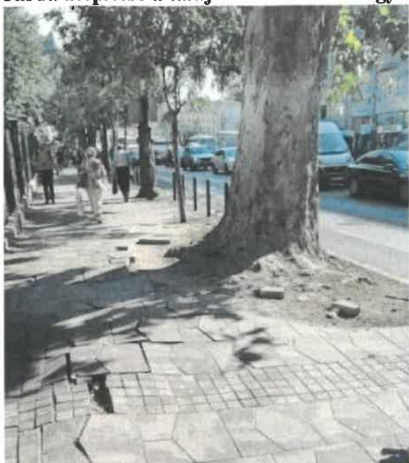
Járda átépítése a talajból kitüremkedő gyökerek miatt (Budapest Múzeum körút) Előtte:
